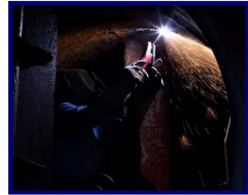
Arc Gouging ( High )
